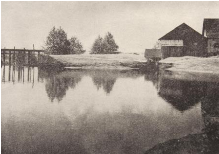
Fot. 1. Mroczków-Kapturów, młyn wodny zbożowy, ujęcie wody (wg Katalog Zabytków Budownictwa Przemysłowego w Polsce , t. 2, Województwo kieleckie , red. J. Pazdur, z. 2, Powiat Kielce , opr. E. Krygier, Wrocław-Warszawa 1959)
