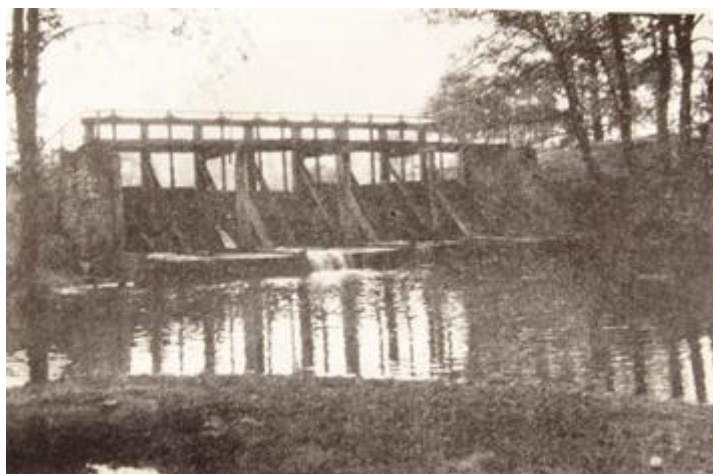
Fot. 6. Baranów, młyn wodny zbożowy, upust jałowy (wg Katalog Zabytków Budownictwa Przemysłowego w Polsce , t. 2, Województwo kieleckie , red. J. Pazdur, z. 2, Powiat Kielce , opr. E. Krygier, Wrocław-Warszawa 1959)
