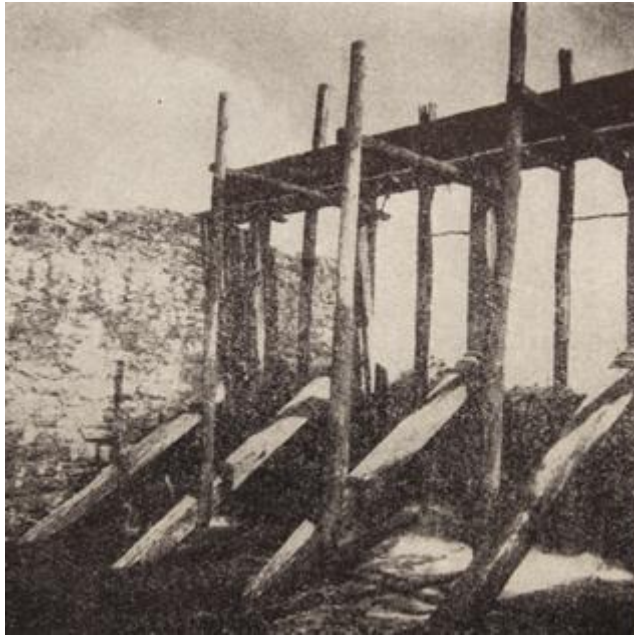
Fot. 2. Mroczków-Kapturów, młyn wodny zbożowy, upust jałowy (wg Katalog Zabytków Budownictwa Przemysłowego w Polsce , t. 2, Województwo kieleckie , red. J. Pazdur, z. 2, Powiat Kielce , opr. E. Krygier, Wrocław-Warszawa 1959)
